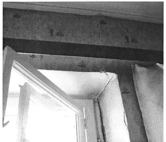
Intensiivistunud pragu krt 3 magamistoa akna (sulgumine raskendatud) juures, enne ja pärast
